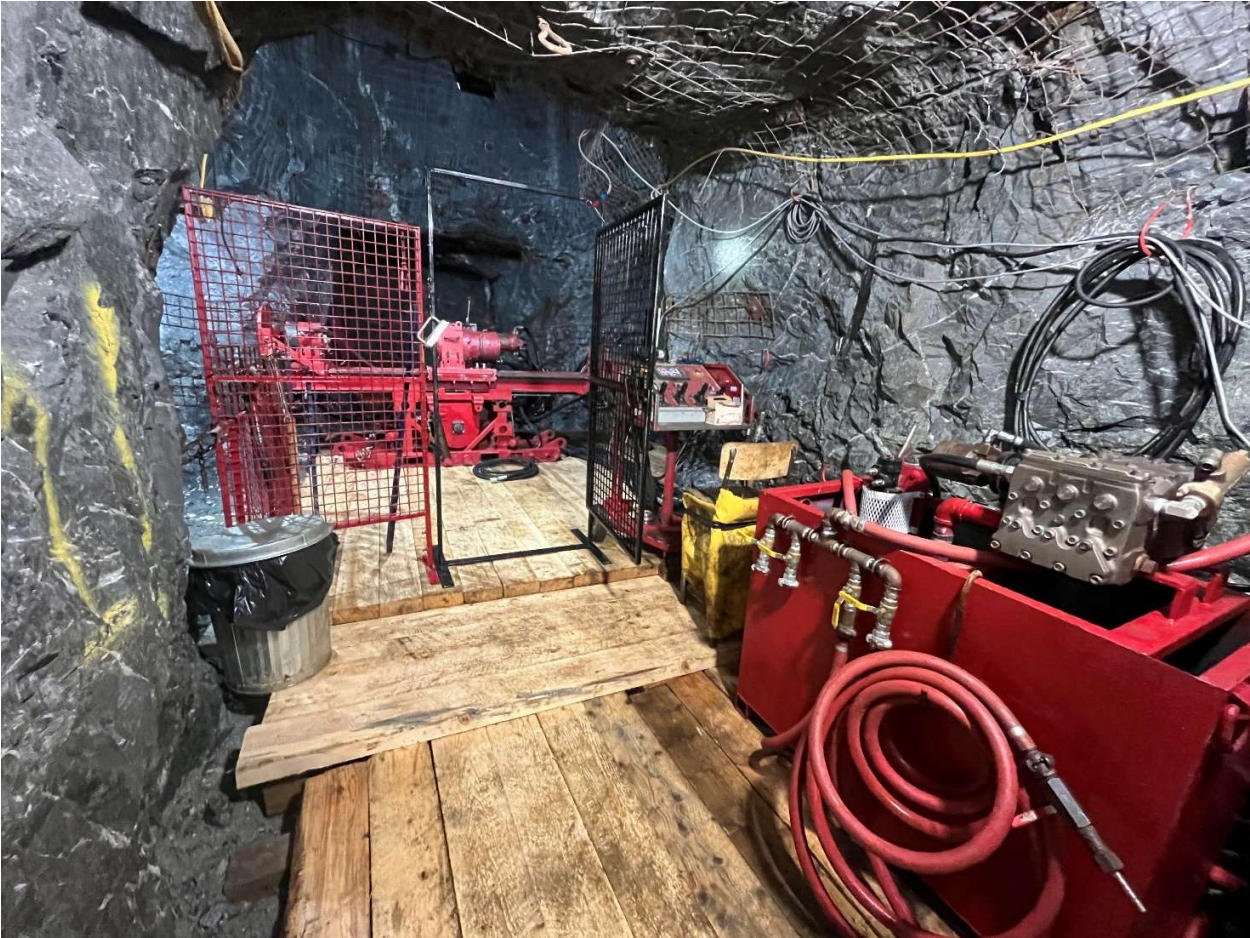
Figure 3: Foreuse au niveau 785 m prête à démarrer le programme.
