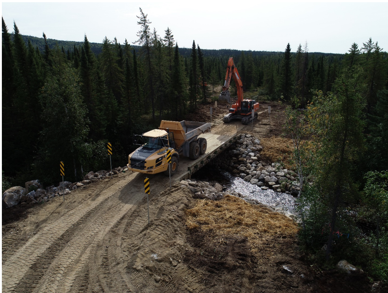
Photo 1 : Pont permanent km 6,75
