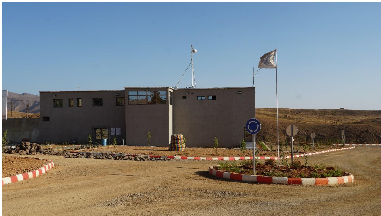
Figure 1 : La construction des nouveaux espaces à bureaux est presque terminée
