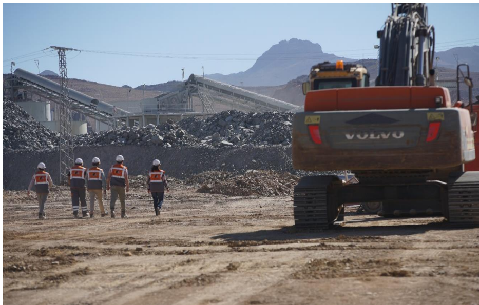
Figure 1 : Terrassement de la nouvelle halde de minerai tout-venant de l'usine de traitement Zgounder
