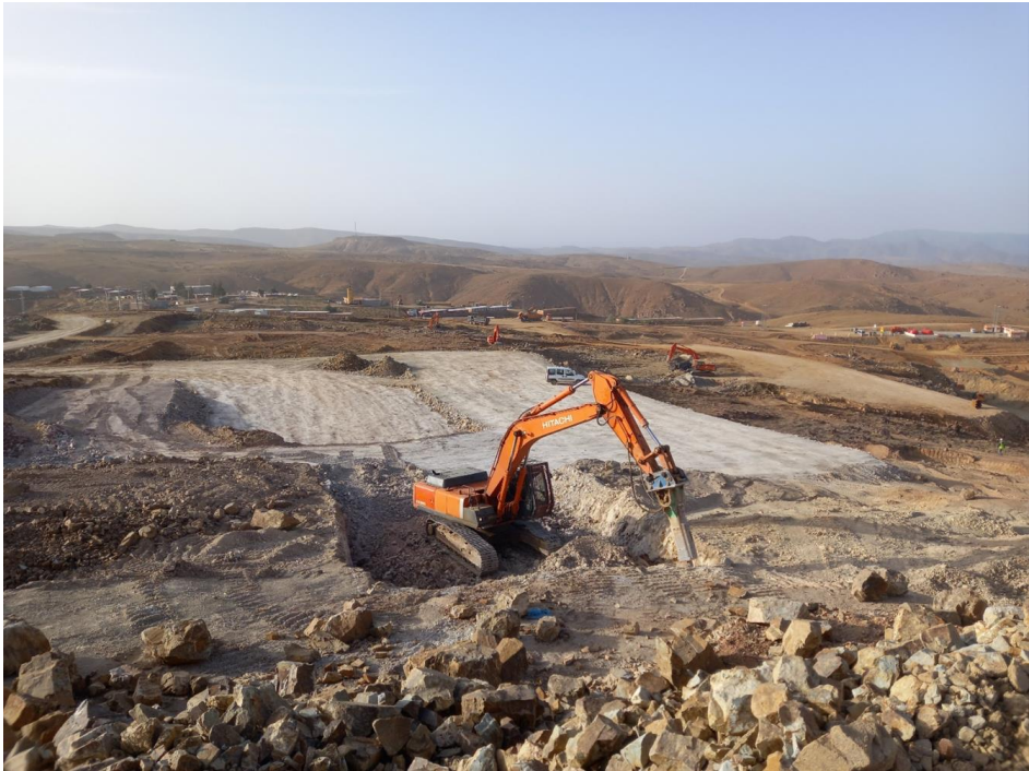
Figure 4 : Terrassement pour la plateforme de la nouvelle usine de traitement Zgounder
