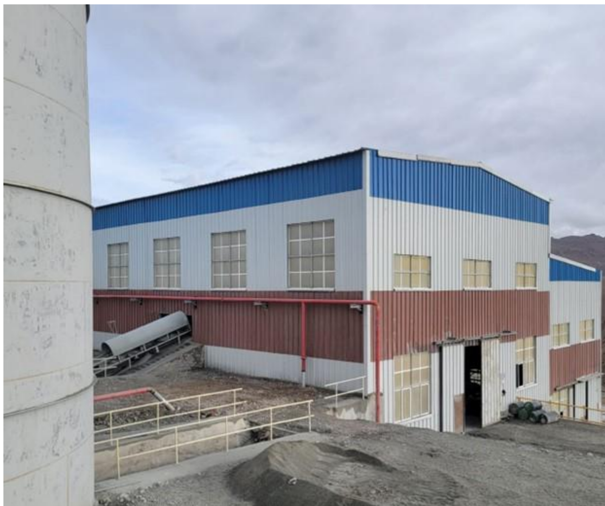
Figure 2 : Installation d'un système de lutte contre les incendies à l'usine de flottation existante
