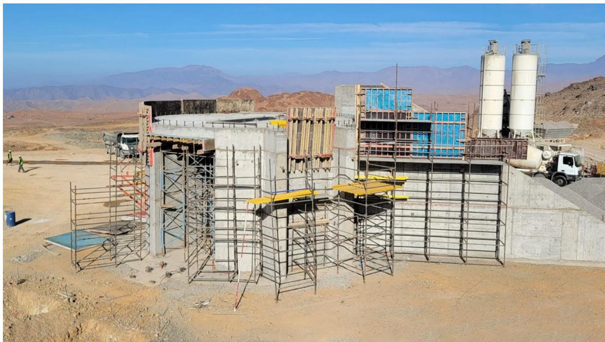
Figure 4 : Construction du silo à minerai en cours
