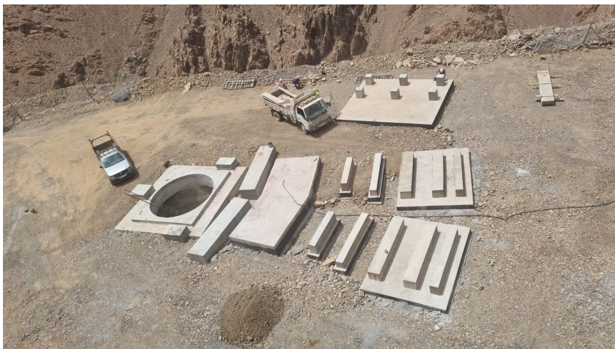
Figure 3 : Achèvement des travaux de génie civil pour le puits et l'équipement de ventilation à Zgounder
