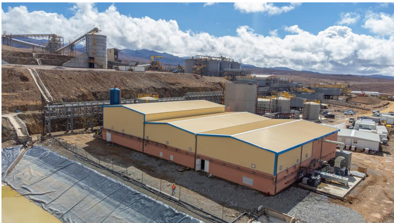
Figure 3 - Nouveau bâtiment abritant le circuit Merrill Crowe et le circuit d'affinage
