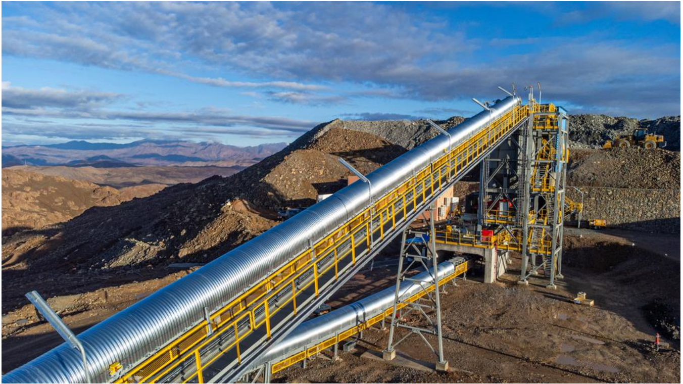
Figure 2 - Mise en service en cours
