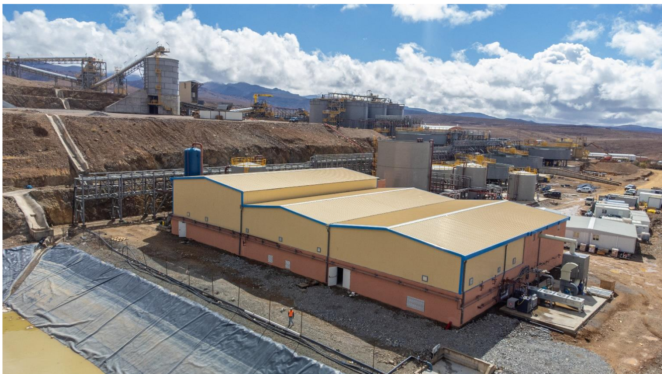
Figure 2 – Nouveau bâtiment abritant le circuit Merrill Crowe et le circuit d'affinage
