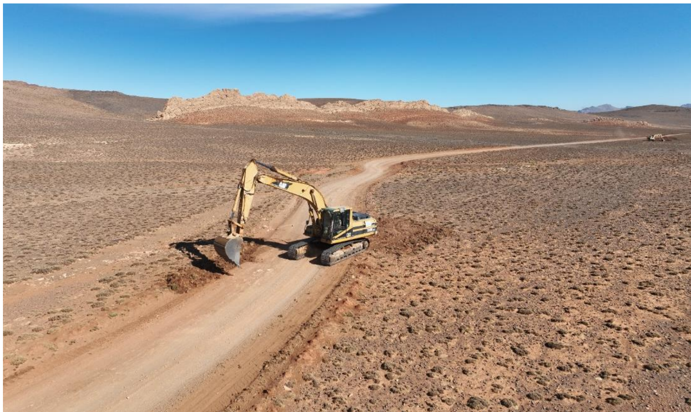
Figure 7 – Réfection et élargissement d'un tronçon de route entre deux villages ruraux
