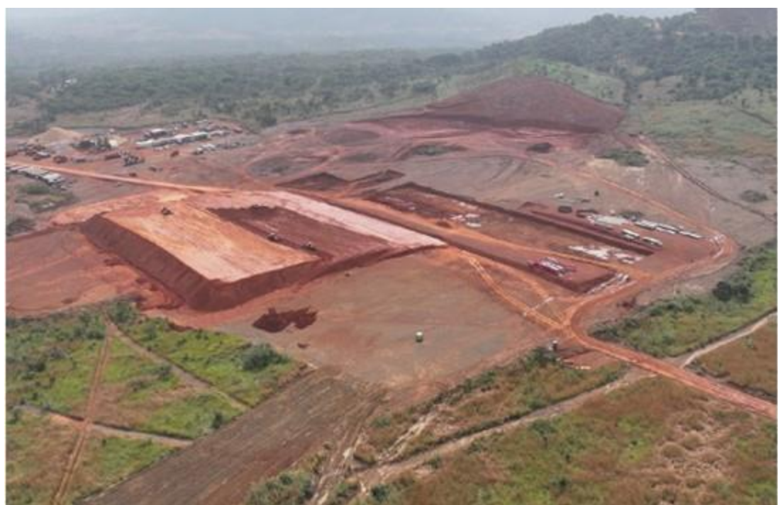
Illustration 5 : Usine de travaux de terrassement
