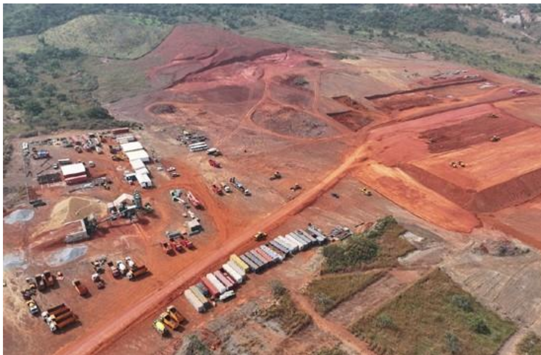
Illustration 4 : Vue d'ensemble du chantier avec la zone de construction KCP (Wacom Group)
